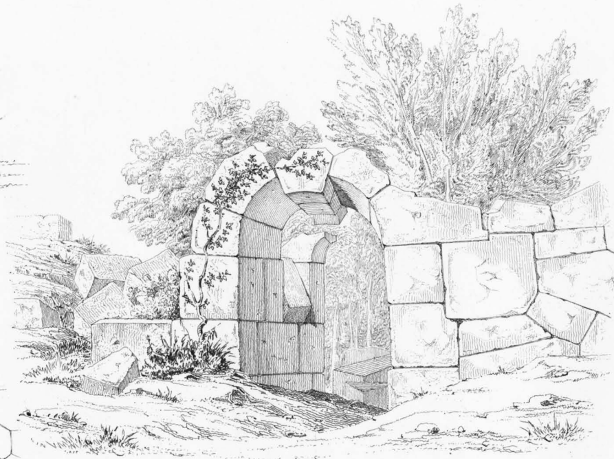
Porte C vue de l'intérieur de l'enceinte
