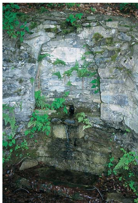
Βρύση στο ρέμα Πόρος
