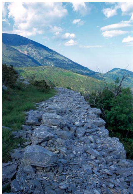
Τμήμα τείχους στο Παλιόκαστρο Καρυάς
