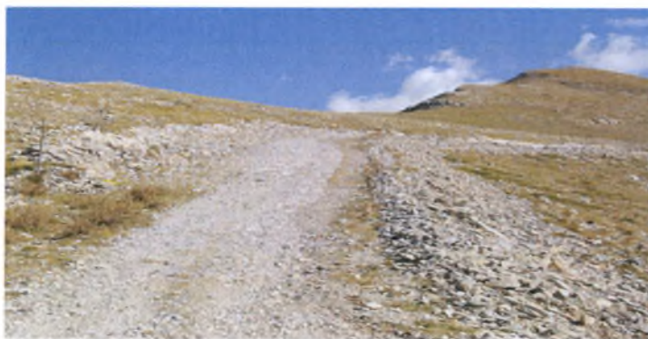
Φώτο 8: Κλίση του δρόμου στη θέση Σμέος
