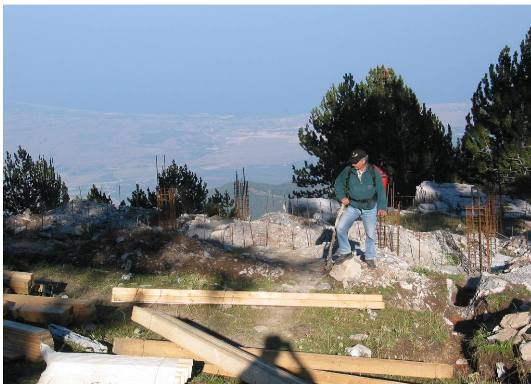
Φωτ. 9: Το ορειβατικό καταφύγιο στη θέση "Πετρόστρουγκα" κατά τη φάση της κατασκευής του. Σήμερα το έργο έχει ολοκληρωθεί και έχει παραληφθεί από τη Δ/νση Δασών Ν. Πιερίας.
