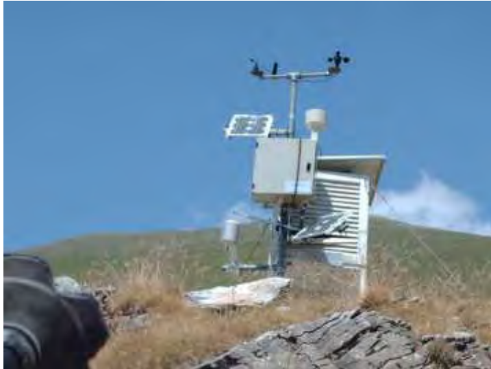
Εικόνα 38: Μετεωρολογικός σταθμός στην είσοδο του Κ.Ε.Ο.Α.Χ.
