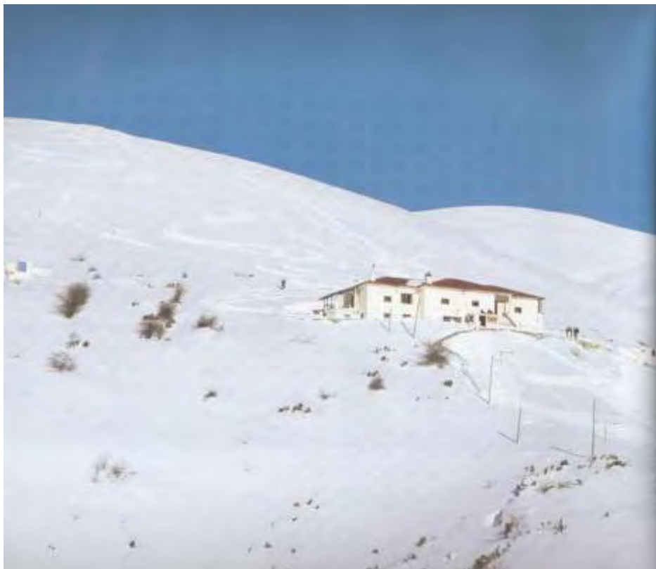
Εικόνα 41: Κτίριο διημέρευσης Κ1 στη σημερινή του μορφή
